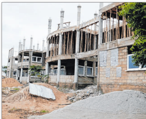
Der Rohbau des Krankenhauses auf einem Foto im Juli dieses Jahres. Foto: Verein
