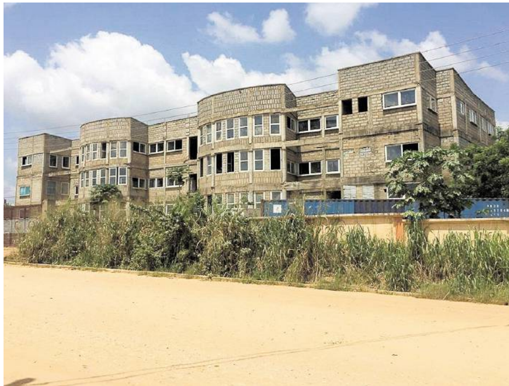
Das Krankenhausgebäude bei Accra ist fast fertig.
